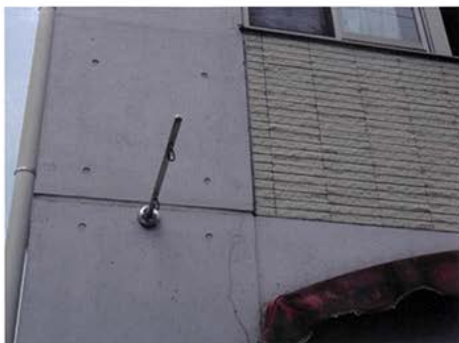
1. 柱梁取り合いひび割れ（震災の影響）
