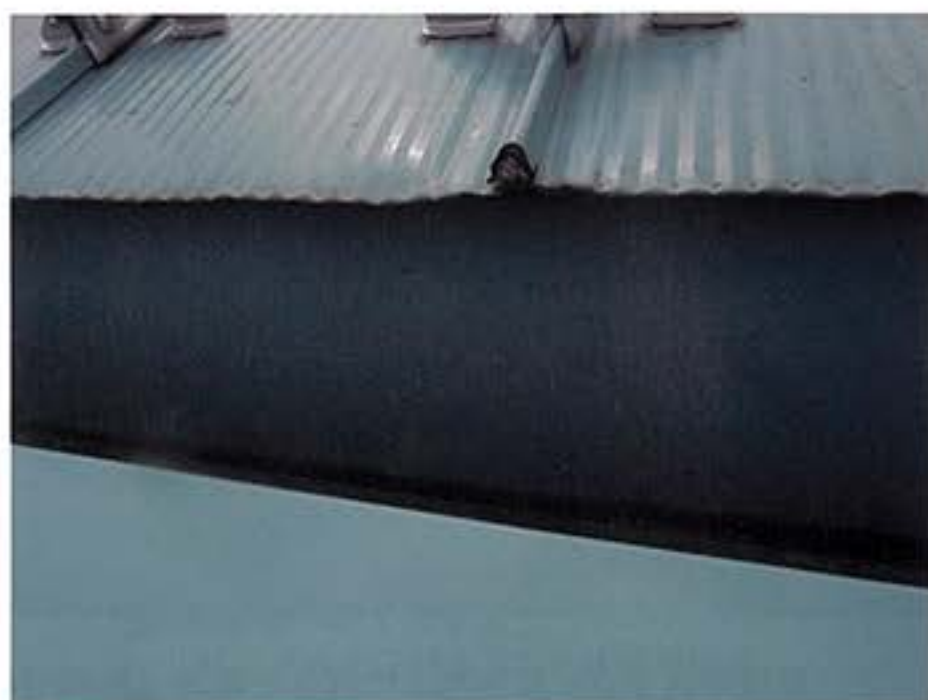
1. ボールト屋根板金端部の様子
