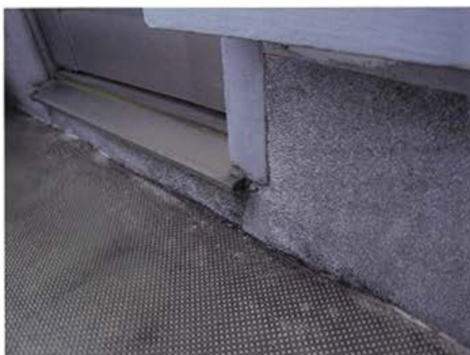
3. 7Fルーフバルコニー床補修状況
