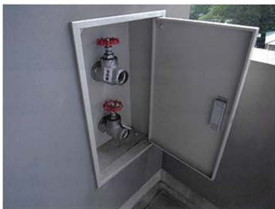
1. 7F 消火ボックス
