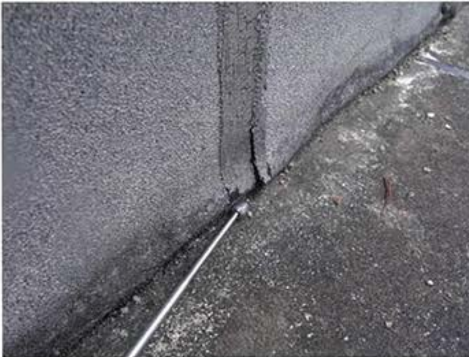
3. パラペット立ち上がり露出アスファルトのヨレ
