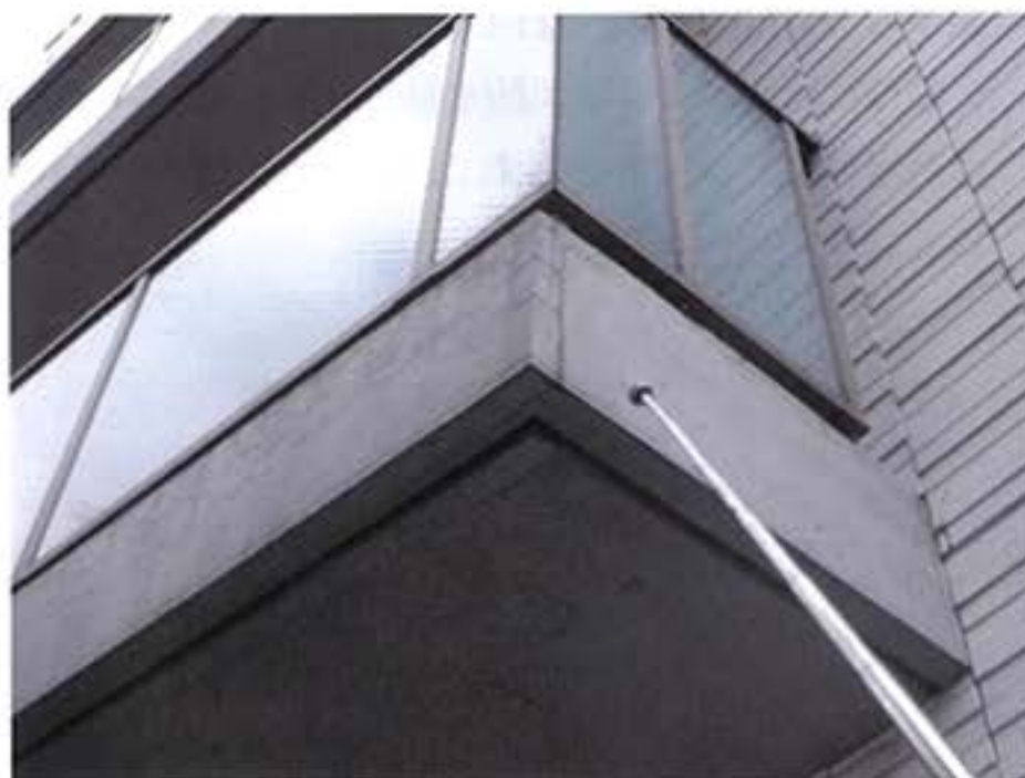
5. 北側バルコニー天端ひび割れの状況
