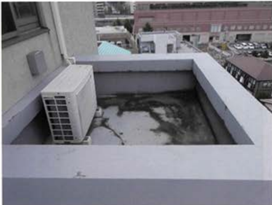
2. E Vシャフト屋根の状況
