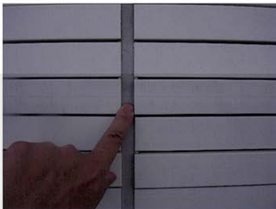
2. EVシャフト屋根の状況
