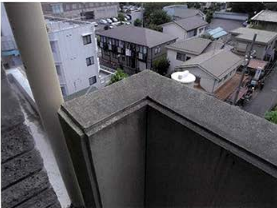
5. 6F手すり壁汚染
