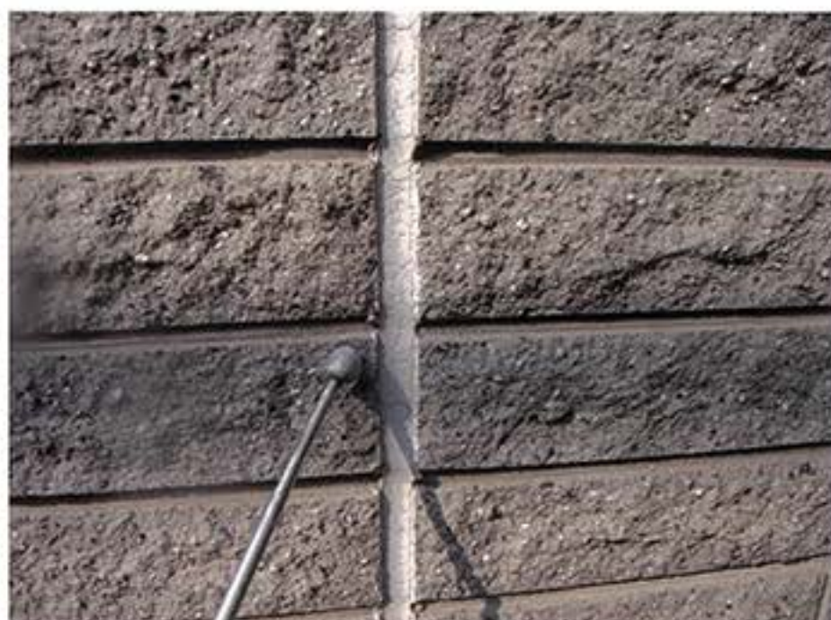
6. 南面平二丁タイル目地
