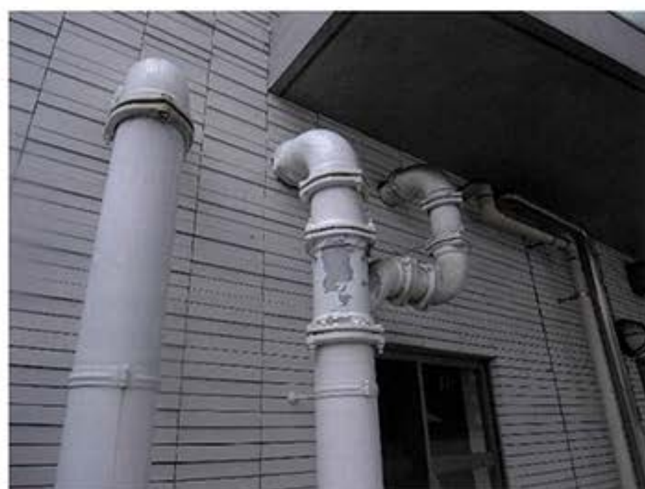
2. 配管塗膜剥離
