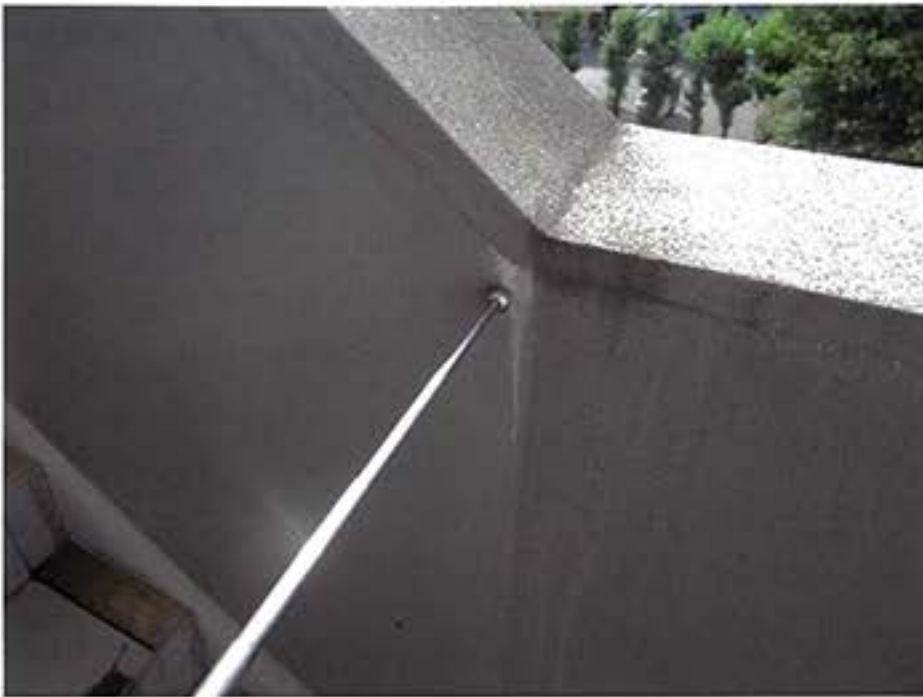
3. 階段手摺り天端ひび割れ+エフロ析出
