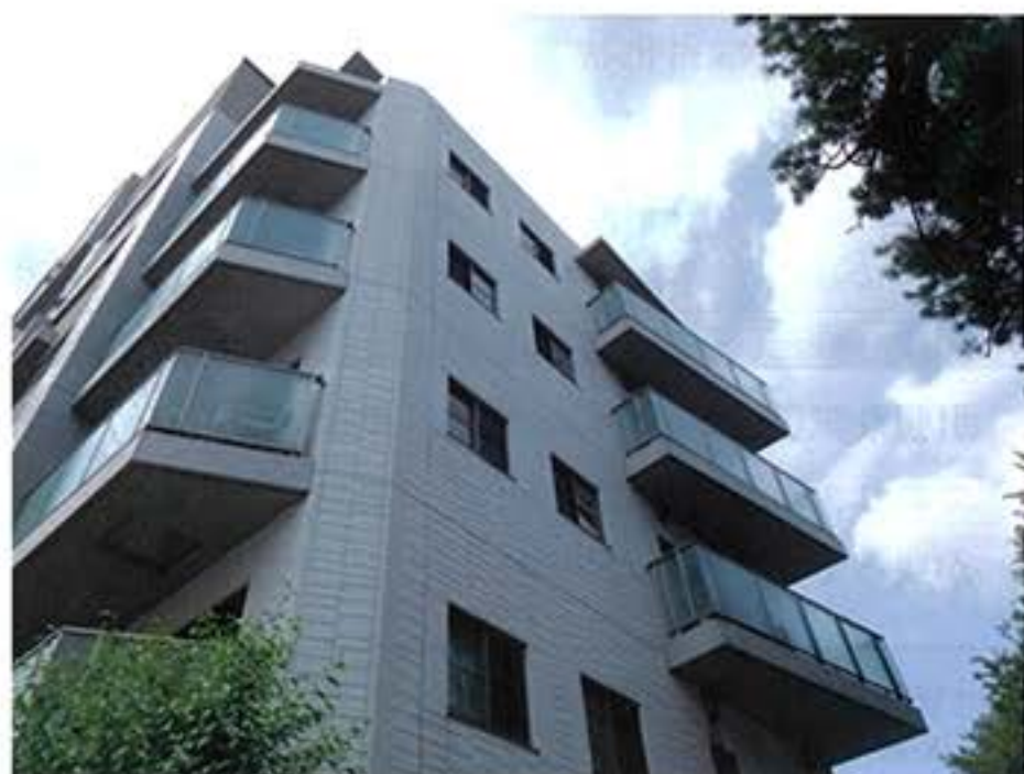
3. 北面ボーダータイル
