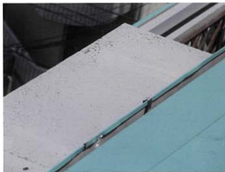
5. 北側小庇の状況
