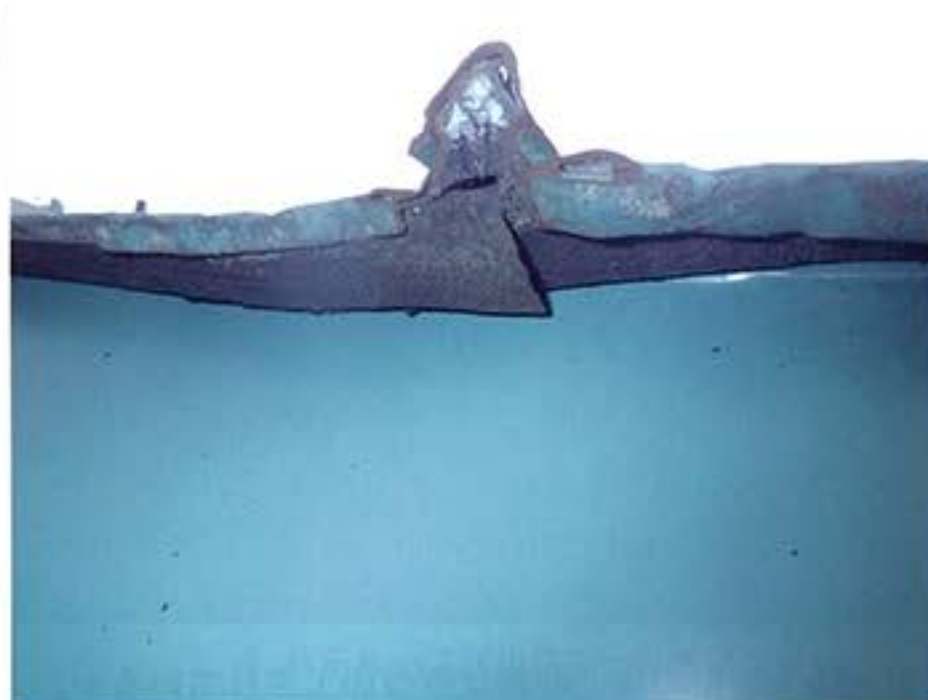
2. ボールト屋根端部破損の状況
