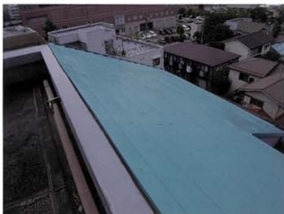
5. 斜屋根の状況
