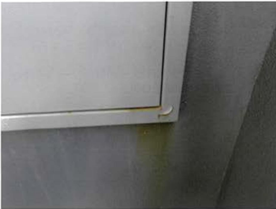
3. 塗膜剥離、錆の発生
