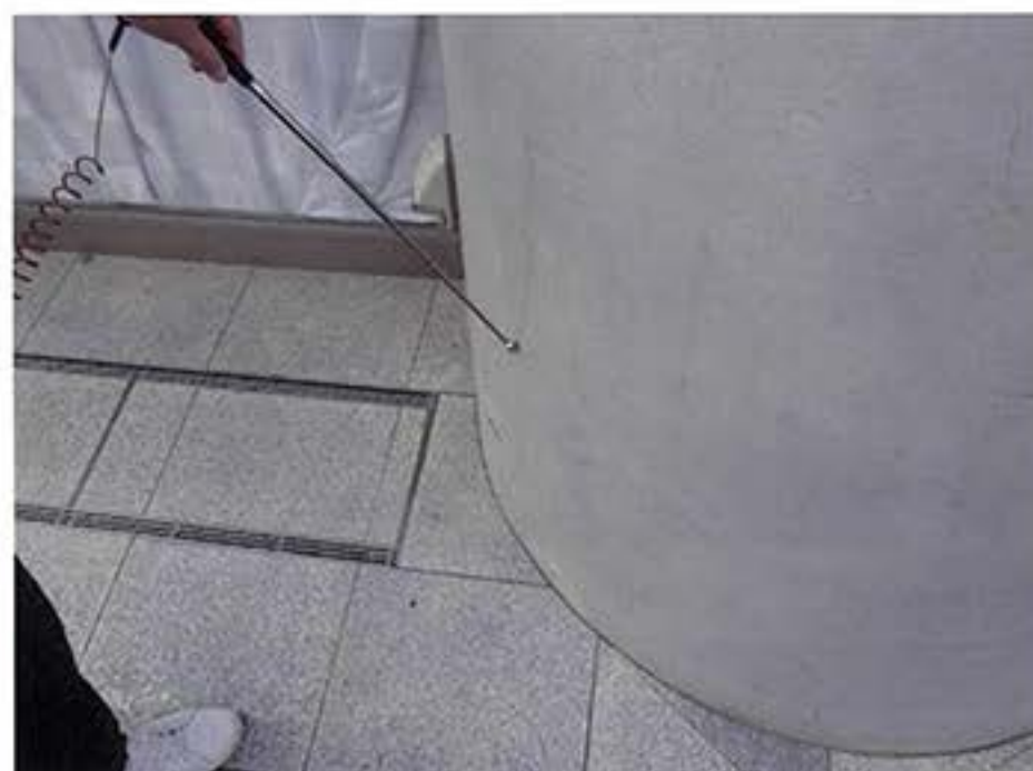
2. 1F丸薄塗りモルタル浮き
