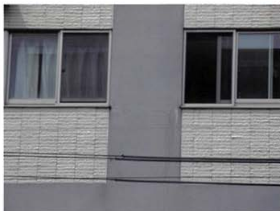
2. 4F南外壁 エフロレッセンスの析出
