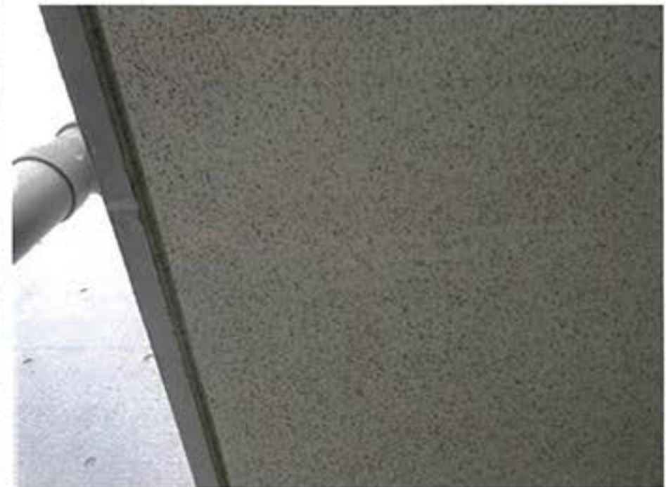
6. 4F共用廊下上裏 ひび割れ
