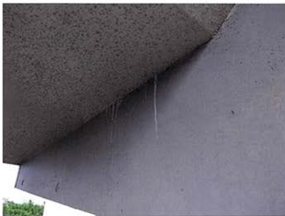
5. 共用階段上裏の様子
