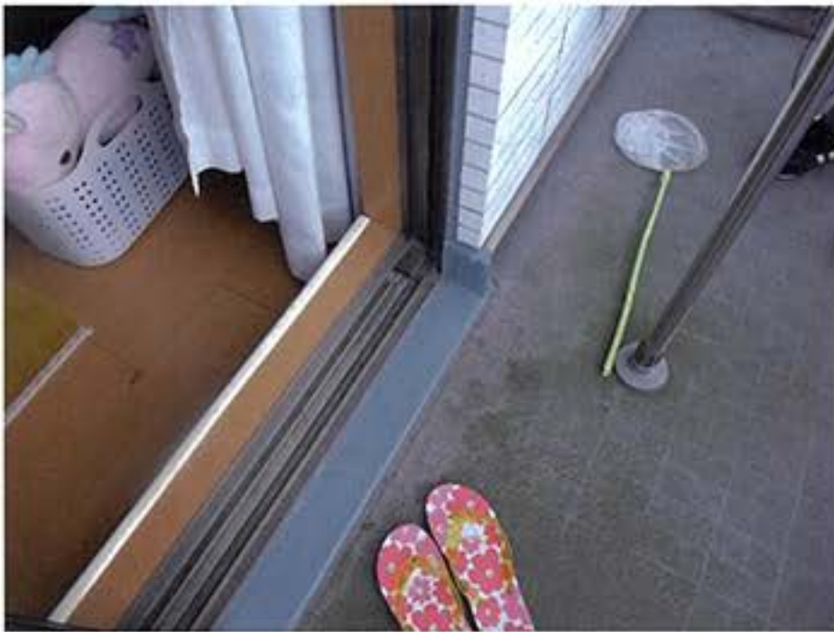
5. 6 F 漏水部分補修状況
