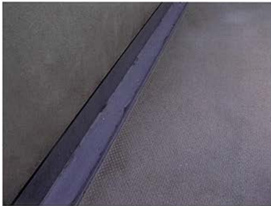
1. 共用廊下側溝部
