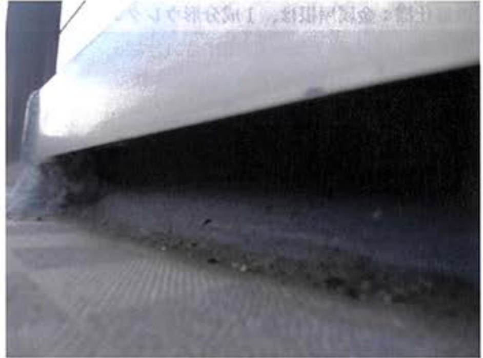
6. 6 F 補修未施工部分
