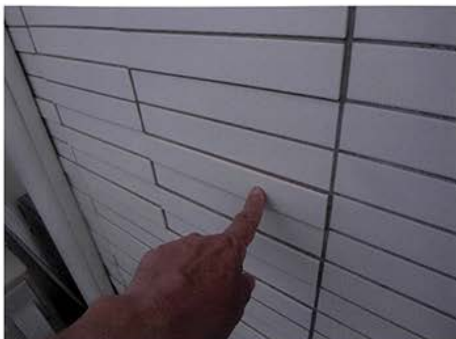
5. 北面6F漏水部分目地埋
