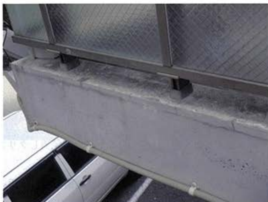
3. バルコニー見付けひび割れ
