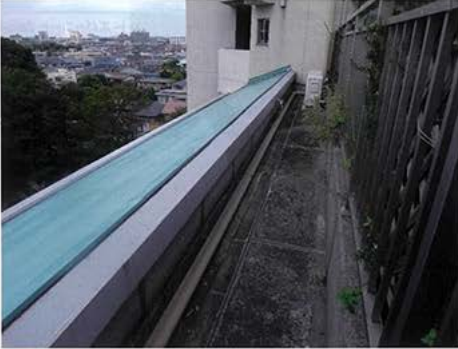
1. 緑化土留めとパラベットの様子
