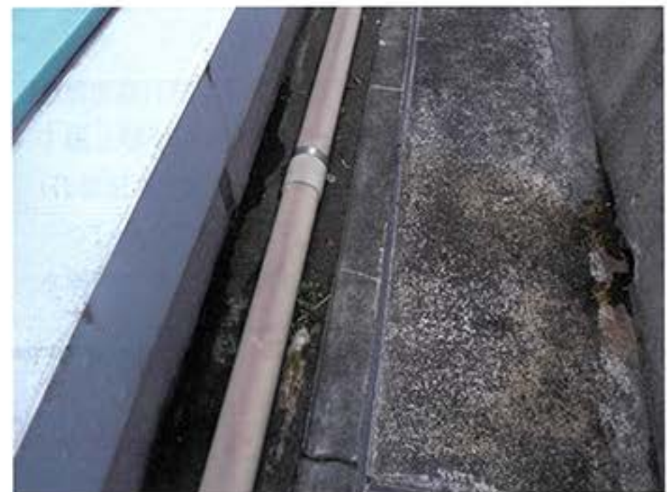
6. 雨水転がし配管と緑化土留めからの絞り水
