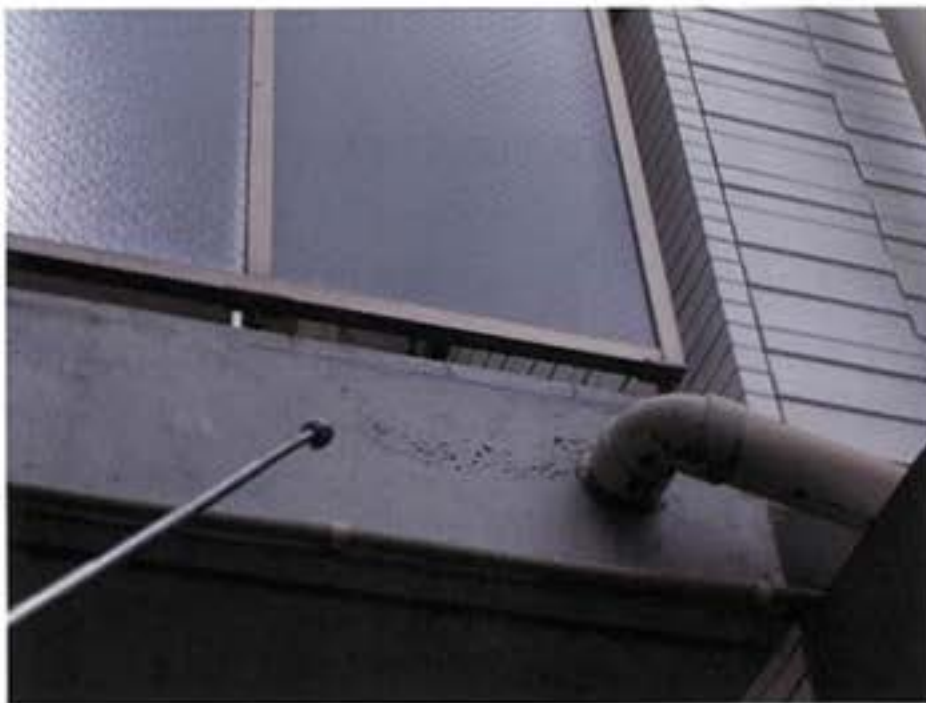
3. 北側バルコニー天端のひび割れ
