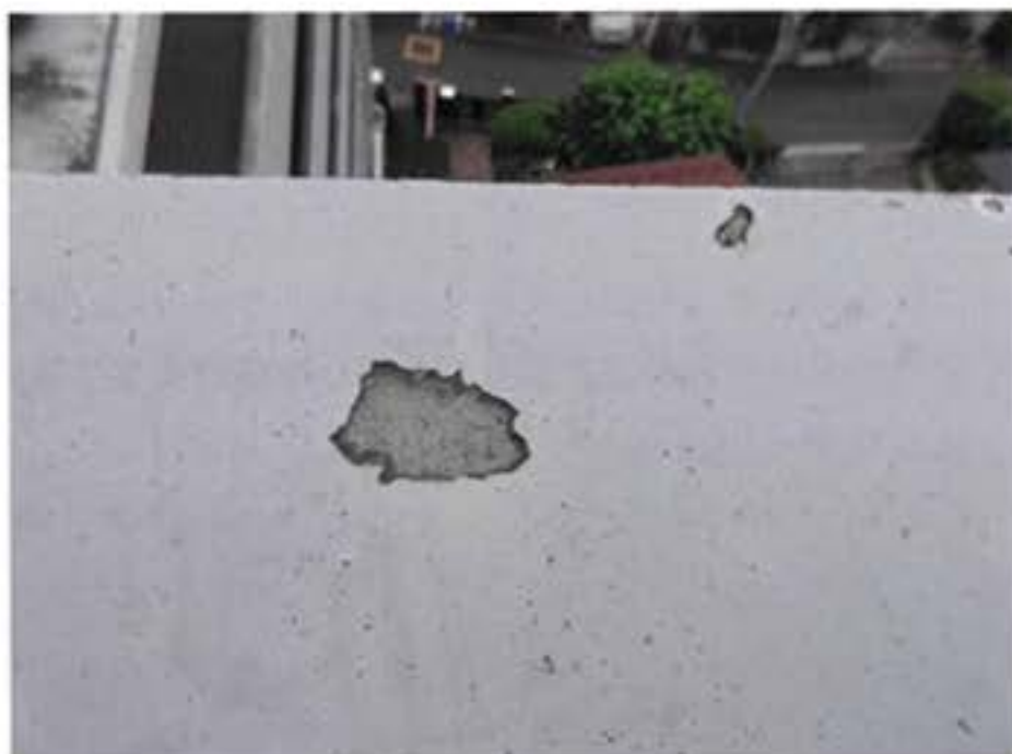
3. E Vシャフト屋根防水剥離
