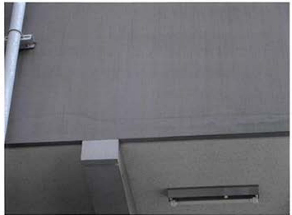
4. 2～3F共用階段手摺壁 ひび割れ
