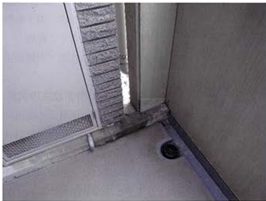
3. 共用廊下ドレン部
