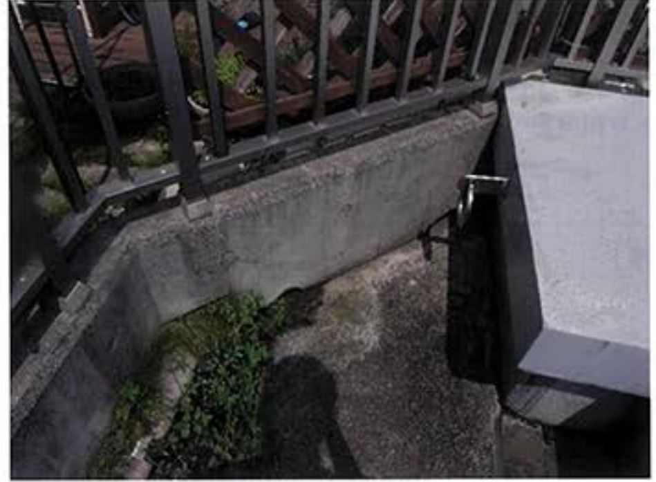
2. 緑化土留め排水部分の植生
