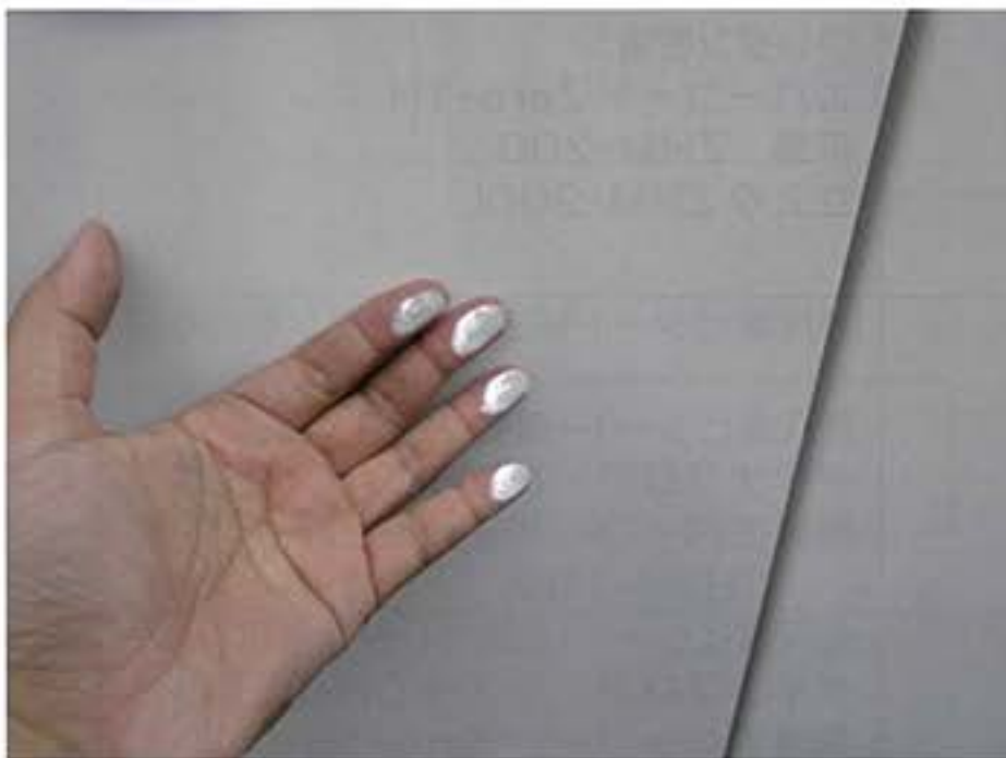
5. 弱電引込盤ボックス 塗膜のチョーキング
