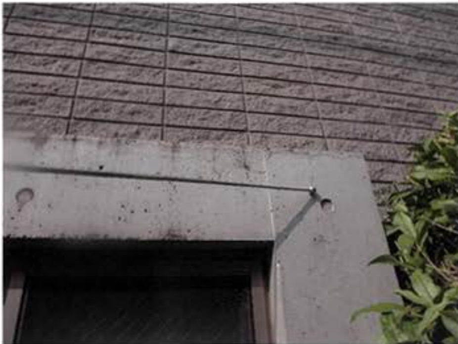
5. 南側出窓劣化
