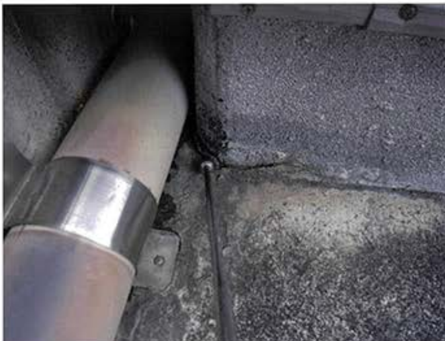
5. 排水管と基礎の狭窄部
