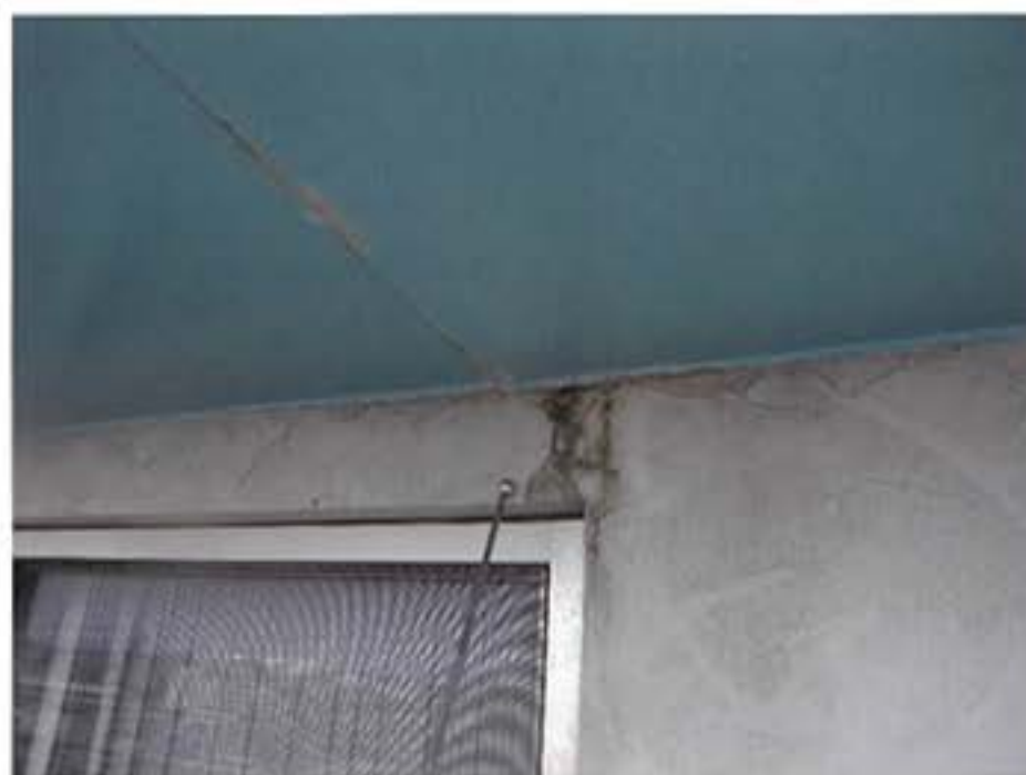
4. 8F 庇板金部分より漏水
