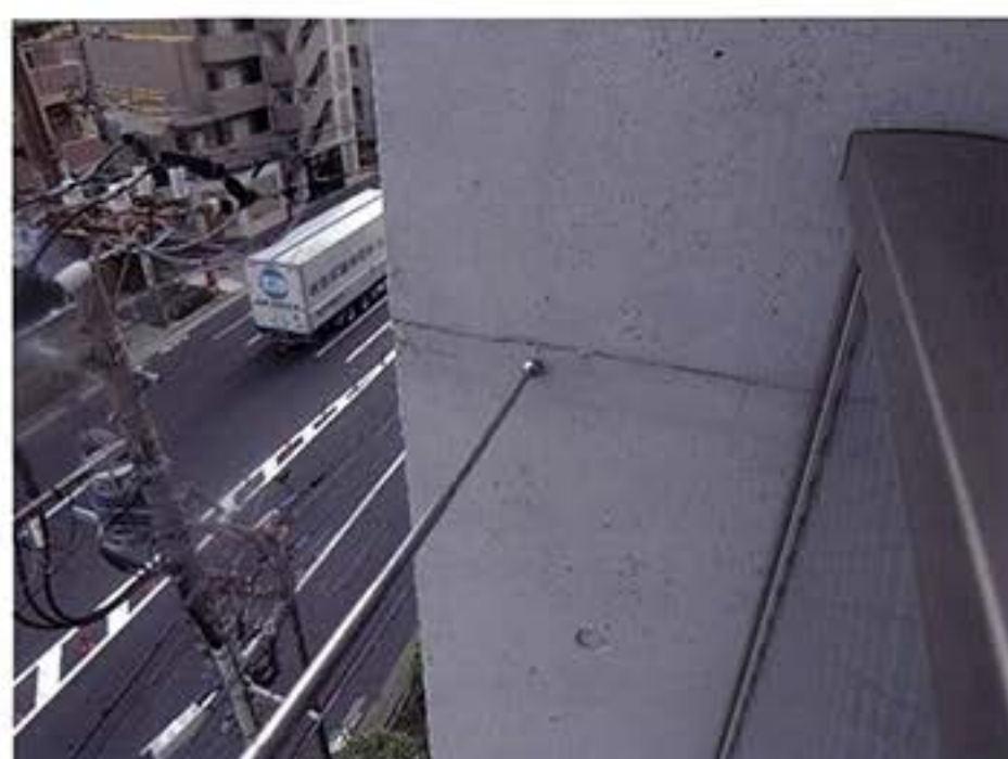
4. 柱打部分ひび割れ（震災の影響）
