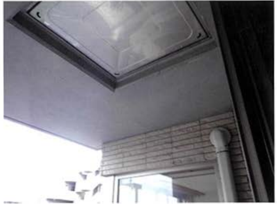
2. 東側バルコニー天井の状況
