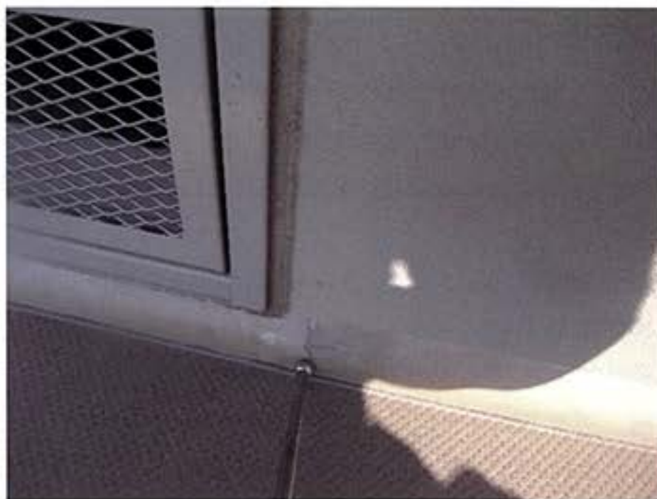
2. 共用廊下巾木ひびわれ
