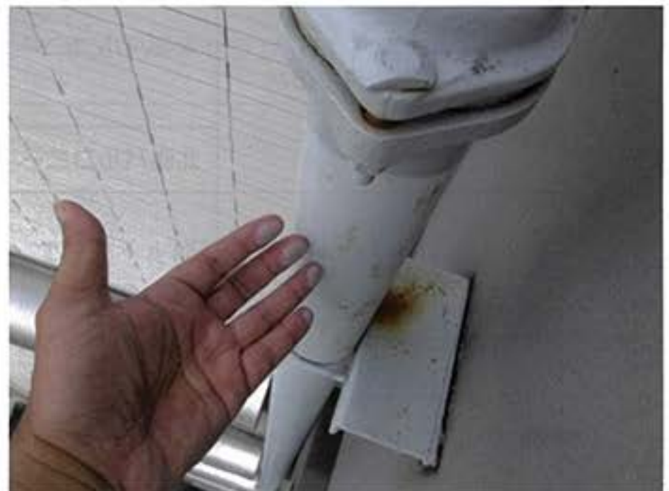
6. 連結送水管 塗膜のチョーキング
