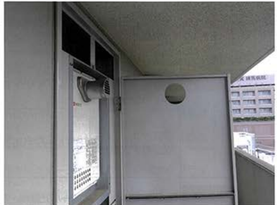
4. 7F 階段扉 塗膜剥離
