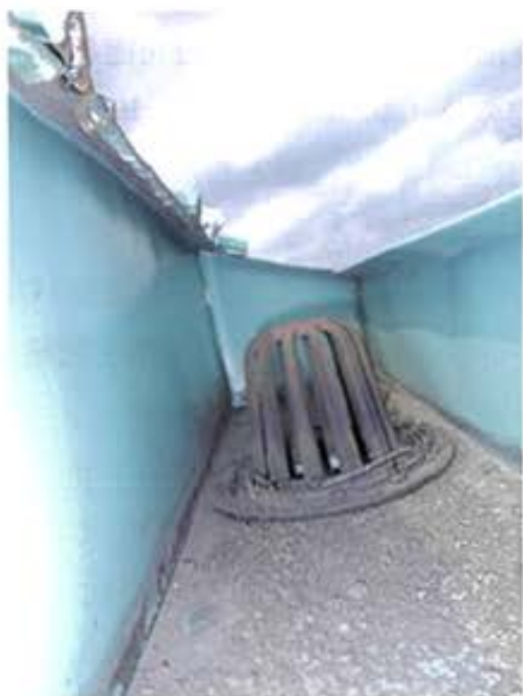
3. ポールト屋根樋部分の納まり
