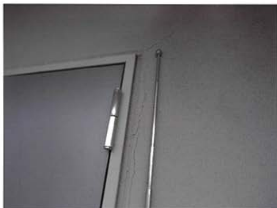
1. 建具廻りのひび割れ
