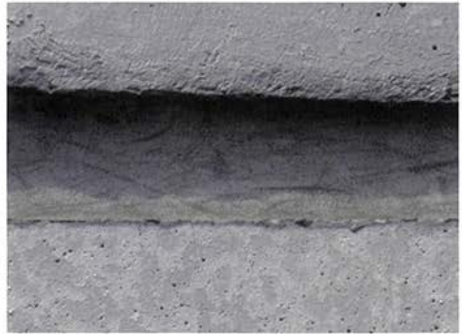
4. 共用階段底ウレタン塗膜減耗
