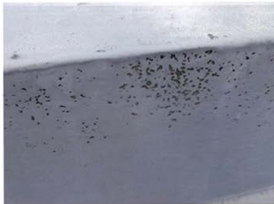
4. 共用階段底ウレタン塗膜減耗
